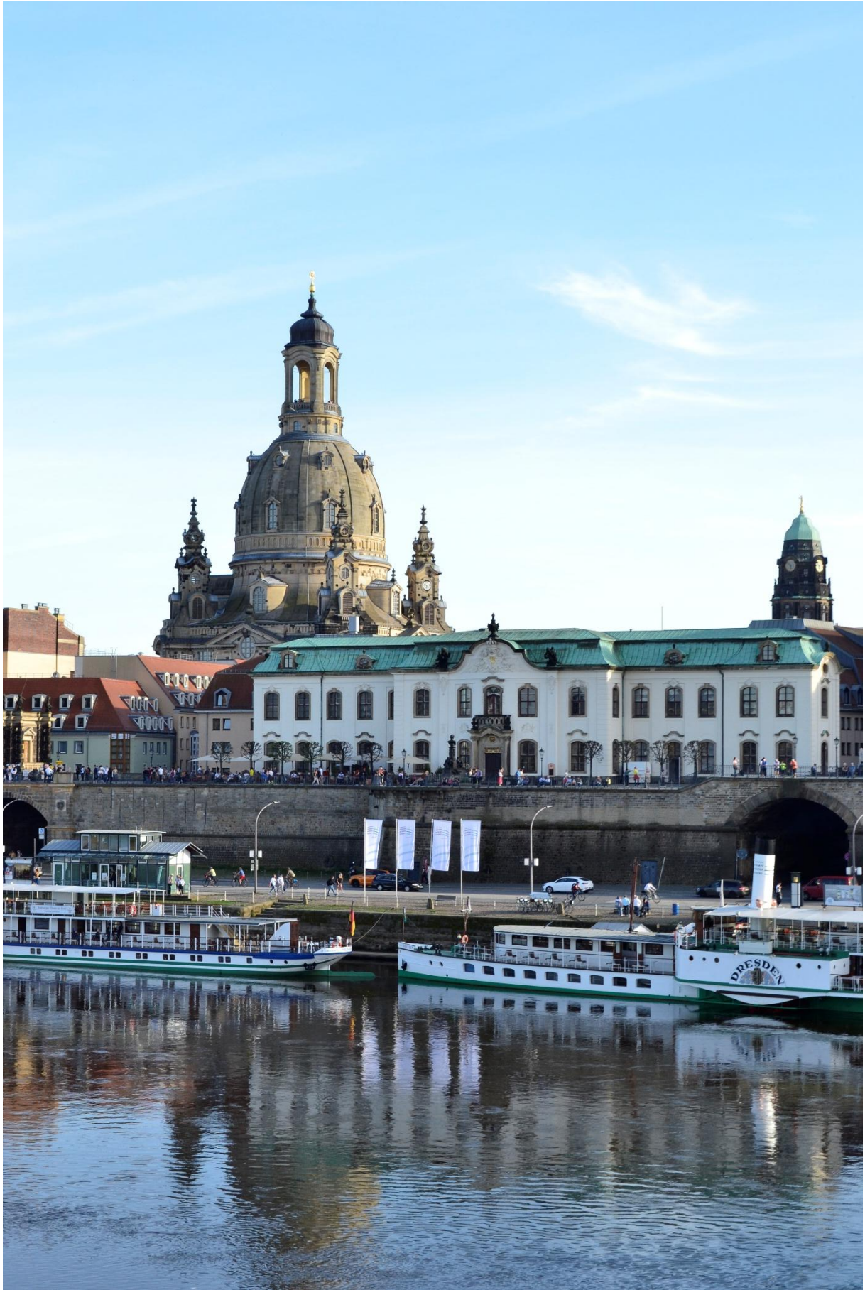
(Abb. 5 Ausblick von der Augustusbrücke 2024; Initiative Carolabrücke)
